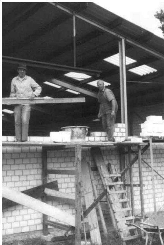
Werner Fischer beim Hallenbau
